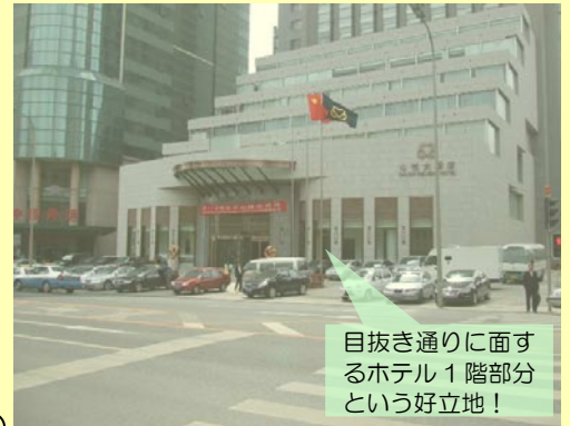
設置場所である大連心悦大酒店外観
